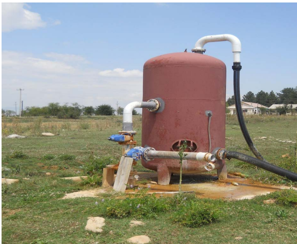
Слика бр. 5: Сепаратор поставен на дупнатината Д-3 за одвојување на гасот \text{CO}_2 од минералната вода
