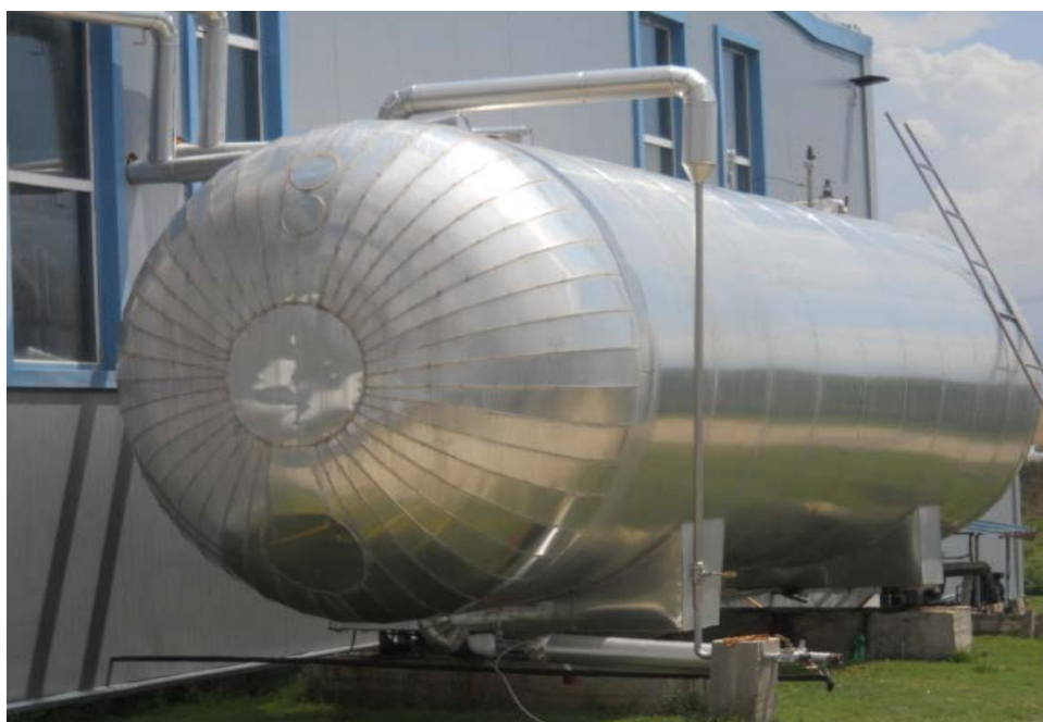
Слика бр. 8: Резервоар за складирање на гас CO 2 од дупнатината Д-3
